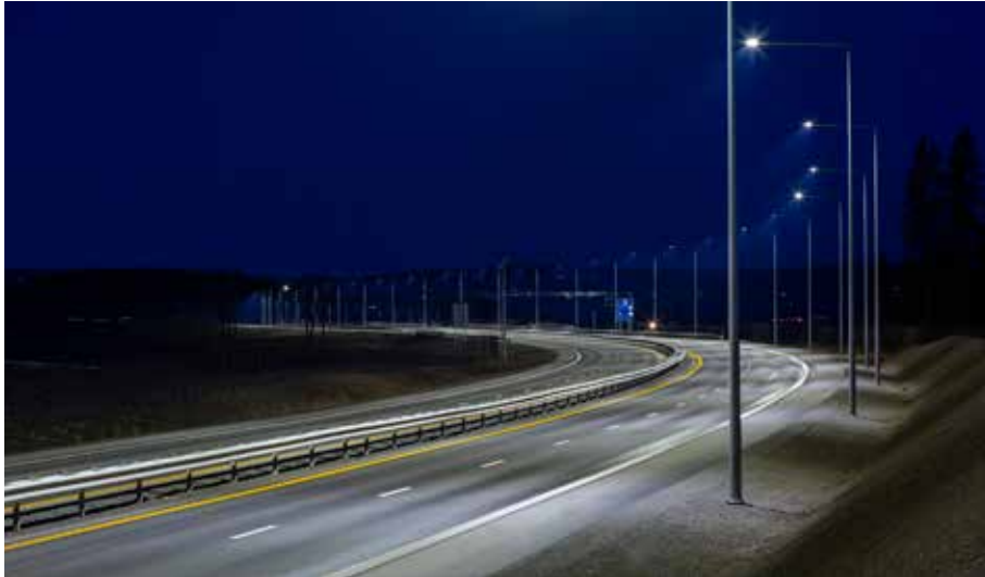
Fig. 5.34: Ensidig veibelysning bør plasseres i utvendige kurver. Moderne LED-belysning kan også belyse en firefelts vei, for eksempel E6 mellom Hamar og Moelv. Foto: Multilux.
