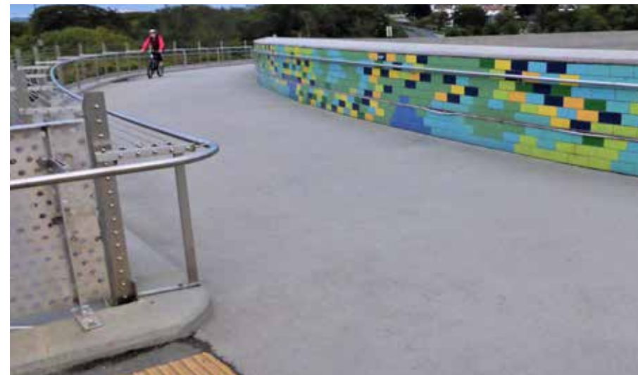
Fig. 5.22: I miljøer for gående og syklende kan bruk av finere materialer som rustfritt stål og flis også være berettiget, som her på Tjensvollkrysset i Stavanger. Foto: Henrik Undeland.
