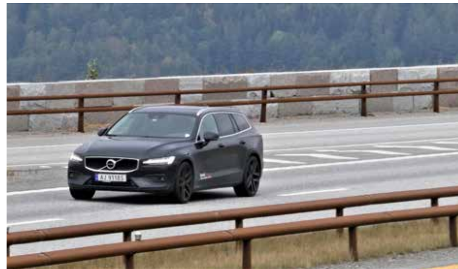
Fig. 3.16: Støyskjermer kan også lages som lave steinmurer, når stedet krever det, som her på vei E6 ved Mjøsa. Foto: Henrik Undeland.
