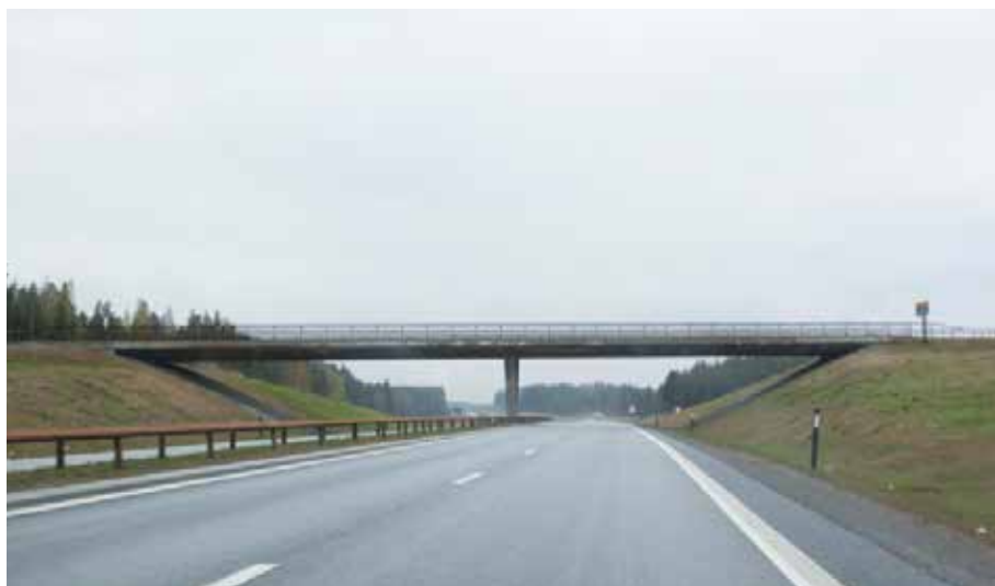
Fig. 5.12: Eksempel på enkel og minimalistisk utformet overgangsbro der terrenget flyter igjennom. Bildet er tatt langs E6 mellom Gardermoen og Hamar. Foto: Marius Fiskevold.
