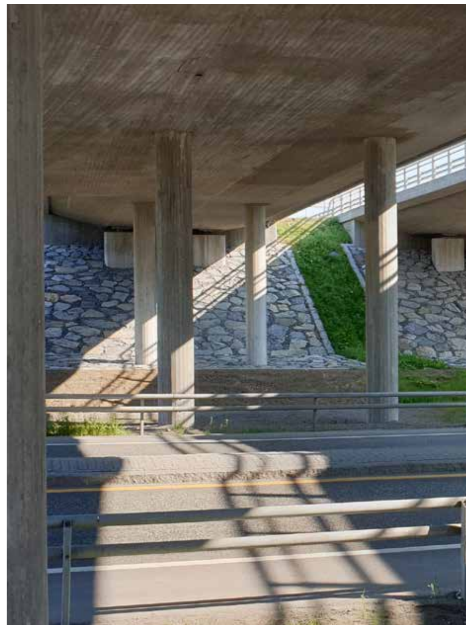
Fig. 2.1 Lyset brytes mot en motorveibro og skaper et nytt, skiftende landskap også under brokonstruksjonen. Foto: Marius Fiskevold
