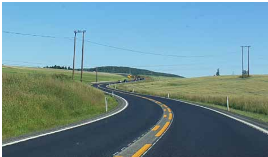
Fig. 4.2: Fotografiet fra E16 ved Hønefoss viser hvordan harmonisk linjeføring samspiller med landformen til jordene. Landskapet oppstår ikke av de enkelte delene, men av samspillet mellom dem. Foto: Marius Fiskevold
