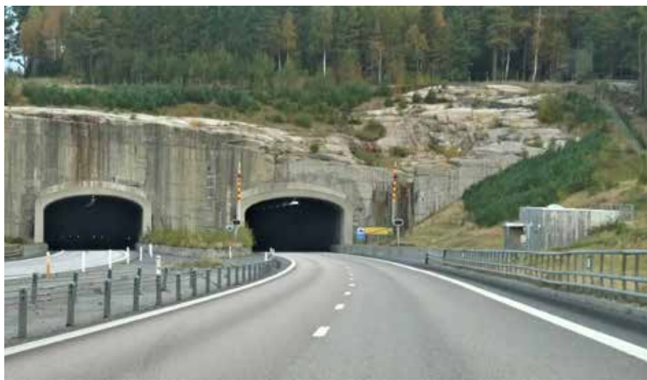
Fig. 5.8: Bildet viser eksempel på et teknisk bygg langs E6 ved Tanum i Sverige. Byggets kledning av tre og plassering i en nisje, gjør at bygget glir godt inn i veiens sideterreng. Bygget opprettholder likevel etterspurt funksjonalitet. Foto: Katharina Nyström.
