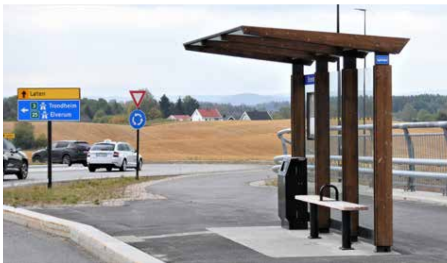
Fig. 5.24: Værbeskyttelse ved bussholdeplassen i trafikkkrysset ved møtet mellom Rv3 og 25. Foto: Henrik Undeland
