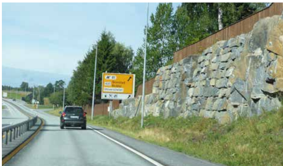
Fig. 5.6: Med sprengt stein fra byggeplassen kan det bygges støttemurer som smelter godt inn mot tilstøtende fjellskjæringer, som her langs E18 ved Grimstad. Foto: Henrik Undeland.
