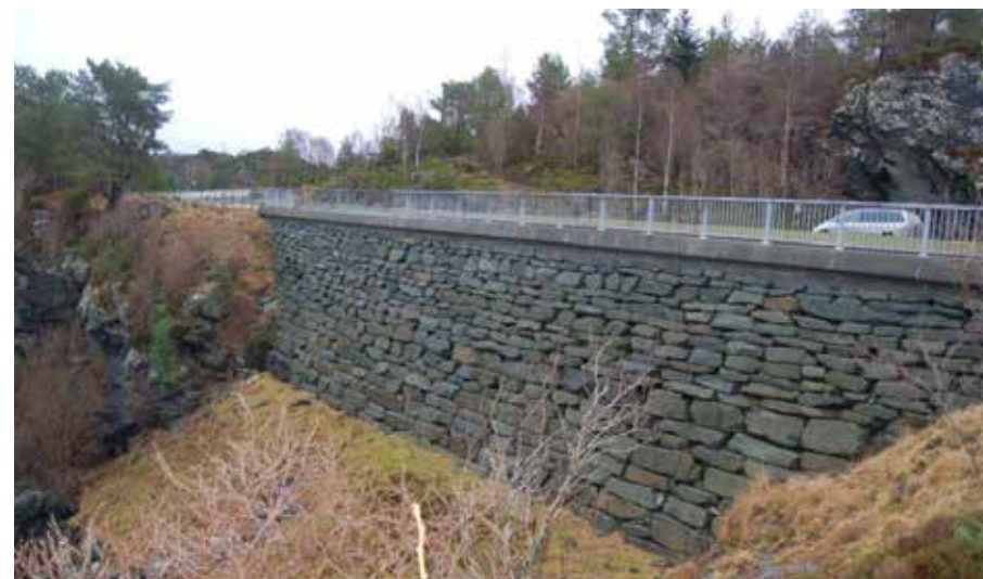
Fig. 5.7: Støttemurer kan utformes på mange måter. Valg av riktig type støttemur til det konkrete landskapet veien beveger seg igjennom vil være avgjørende for anlegget. Bildet over viser en støttemur i naturstein. Bildet er hentet fra nettsiden til Karmøy naturstein.
