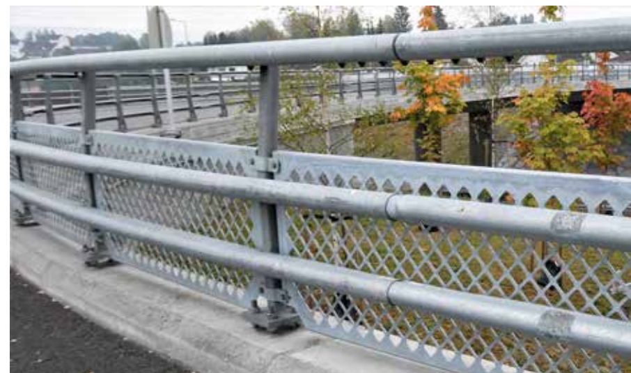
Fig. 5.23: Ved konsekvent bruk av varmegalvanisert stål på alt veiutstyr oppnås også et godt helhetsinntrykk. Legg merke til rekkverkets utforming. Bilde fra Åkerkysset, E6 nær Hamar. Foto: Henrik Undeland.
