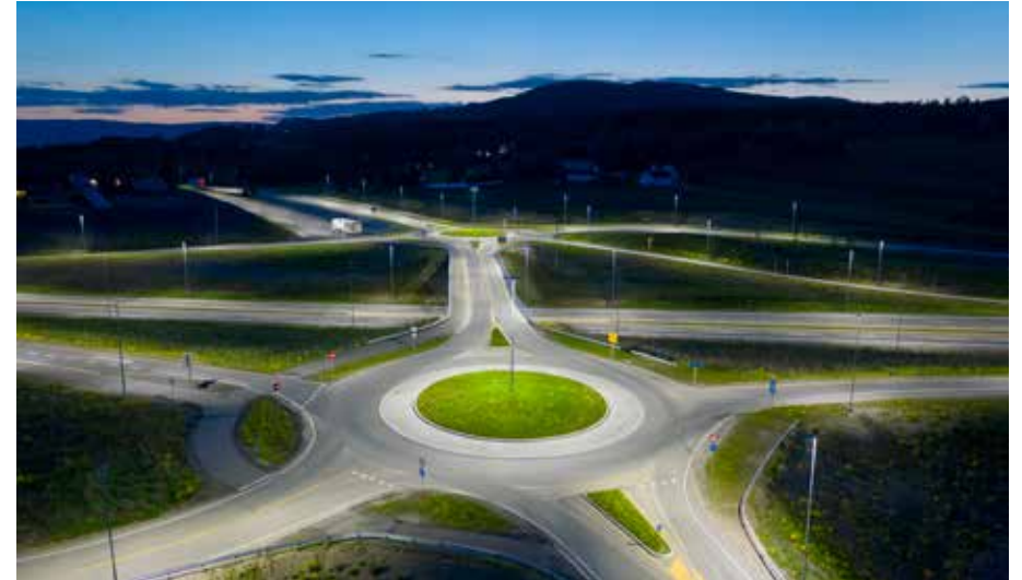
Fig. 5.36: Denne rundkjøringen på E6-delen mellom Hamar og Moelv viser hvordan en sentralt plassert belysningsmast gir god belysning av rundkjøringens senter og kjøreflater. Foto: Multilux.
