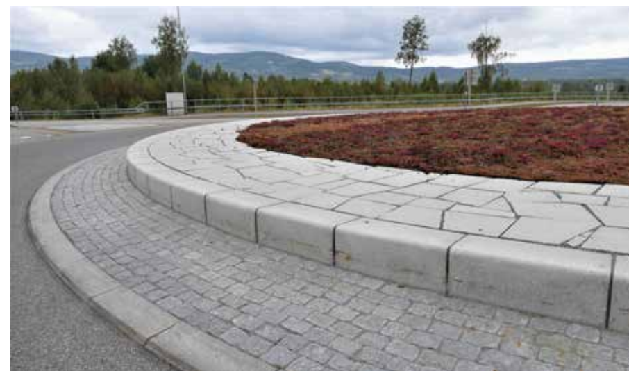
Fig. 5.29: Eksempel på en vakker rundkjøring med høy kvalitet i veikryss på vei E16 vest for Kongsvinger Foto: Henrik Undeland.
