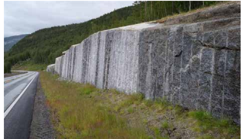
Fig. 4.9: I noen situasjoner kan en loddrett og tett fjellskjæring begrunnes for å redusere forstyrrelser på fjellsiden og gi en skarp, elegant avgrensning til omgivelsene. Foto: Marius Fiskevold.
