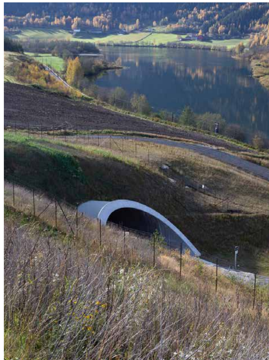
Fig. 3.1: Reetablering av jorde og omlagt driftsvei/turvei over tunnelportal opprettholder dyrkingsareal og tilgang til strandsonen ved elva. Foto: Marius Fiskevold
