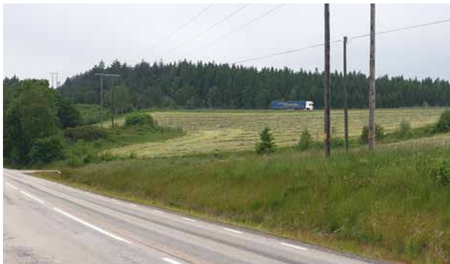
Fig 3.9: Eksempel på et stort masselager inntil en høy steinfylling for å skape en bedre tilpasning til landskapet og gjenskape dyrkbar mark inntil E6 sør for Ljungskile i Sverige. Foto:Henrik Undeland
