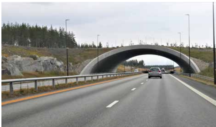
Fig. 5.16: Godt utformet faunapassasje på bro over Rv 3 mellom Løten og Elverum. Vegetasjonen på lokket er under etablering. Foto: Henrik Undeland.
