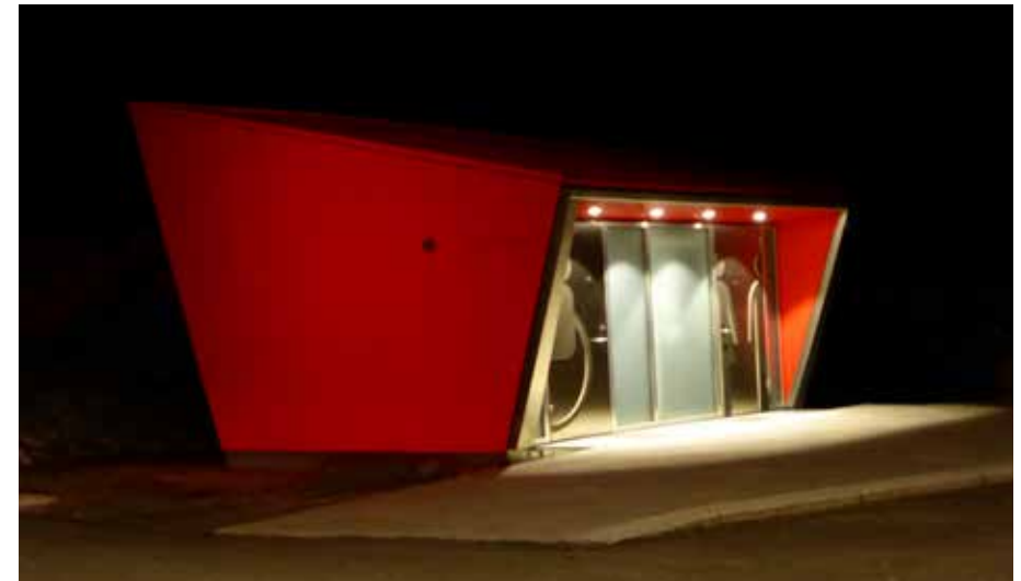
Fig. 5.40: Rasteplassbygningen lyser innbydende for trafikanter på E6 ved Andelva nord for Gardermoen. Foto: Henrik Undeland
