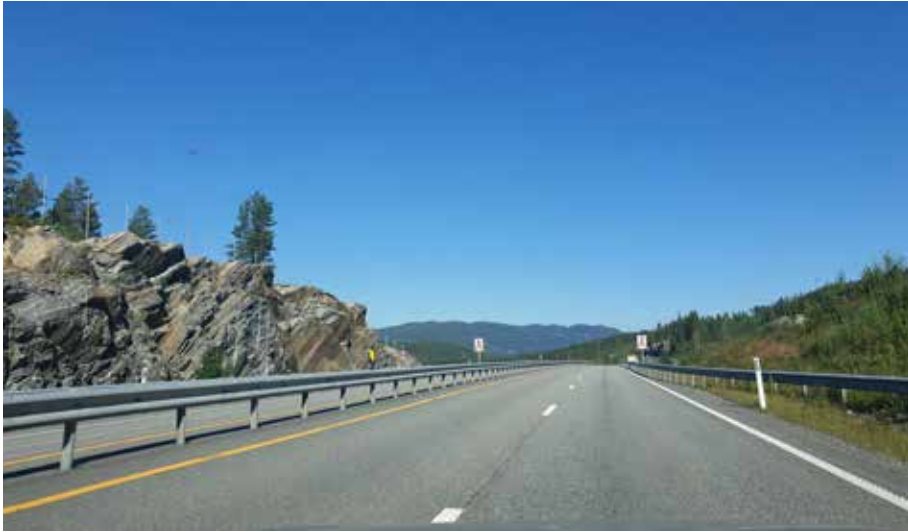
Fig 4.6: Ved utførelse av et "naturlig" kutt kartlegges bergart, slik at sprengningen kan tilpasses bergartens egenskaper og en kan redusere oppryddingsbehovet. Riksvei 7 mellom Sokna og Örgenvika. Foto: Marius Fiskevold..
