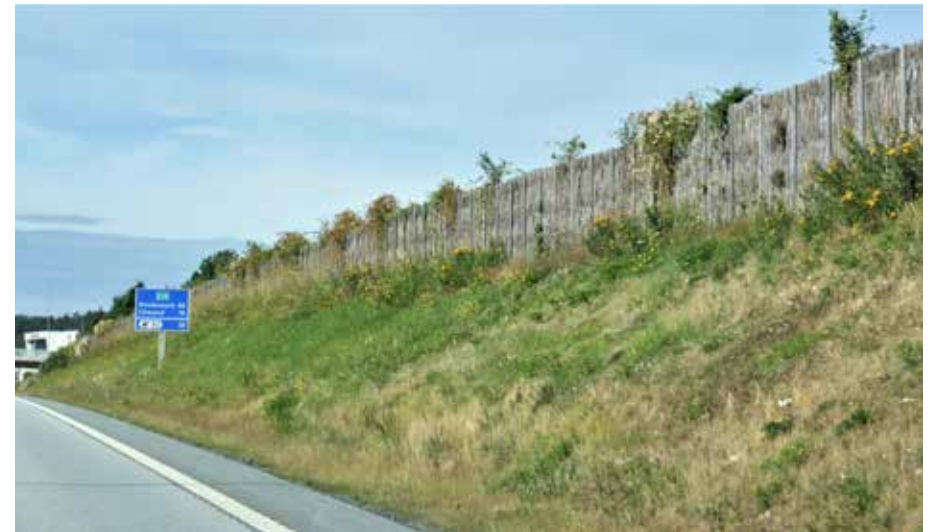
Fig. 3.15: Gressbelagt, bratt støyvoll med støyskjerm på toppen. Bilde fra E18 ved Grimstad. Foto: Henrik Undeland.
