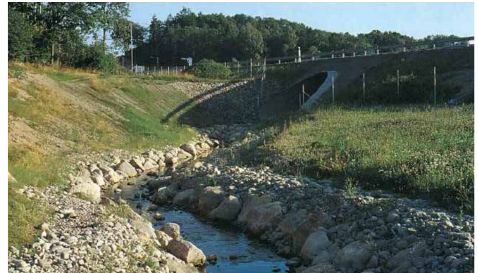
Fig. 4.19: Godt eksempel på en omgravd og naturlig utformet bekk under veiutbygging. Restebäcken under E6 nord for Ljungskile i Sverige. Foto: "Skredkommisionens rapport 2:95".
