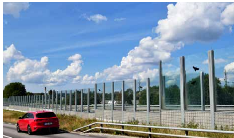
Fig. 3.11: Støyskjermer av glass tillater utsikt og reduserer følelse av innesperring for de som bor ved siden av veien, som her langs E20 ved Lerum i Sverige. Foto: Henrik Undeland.
