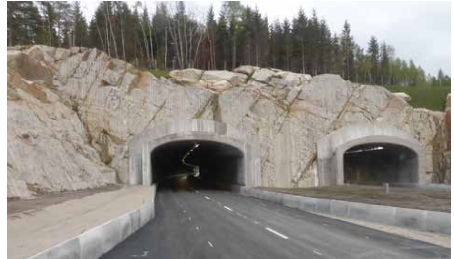
Fig. 5.20: Portalområder som ligger med dype forskjæringer utformes med utgangspunkt i fjellets beskaffenhet. Foto: Henrik Undeland.
