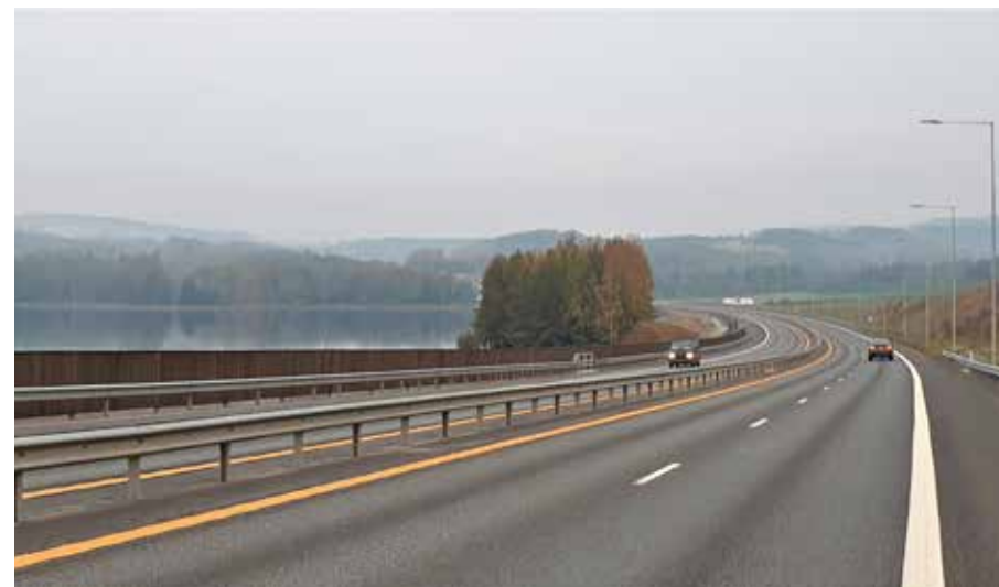
Fig 5.3: Bevaring av naturelementer, som denne trelunden mellom E6 og Mjøsa nord for Brumunddal, bidrar til at hele veianlegget fremstår som et godt gjennomtenkt byggverk.. Foto: Henrik Undeland
