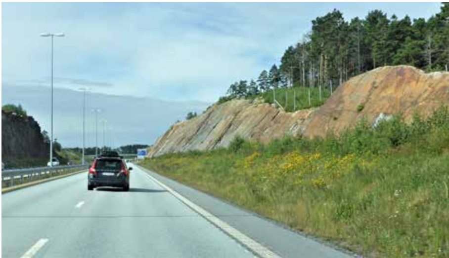
Fig 4.7: Fjellveggene langs en vei er viktig del av sideterrenget. Skråninger legges med helning for å minimere rekkverksbehov. Fjellskjæringer skal tilpasses bergets kvalitet. Fjellets helning vil variere etter de gitte forhold. Bildet er tatt på E18 mellom Grimstad og Kristiansand. Foto: Henrik Undeland.
