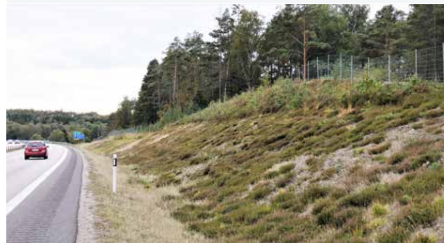
Fig. 3.19: Sideterreng med tilført skogsjord får en rask revegetering med gress, lyng og furu som her langs E6 sør for Tanum i Sverige. Foto: Henrik Undeland.
