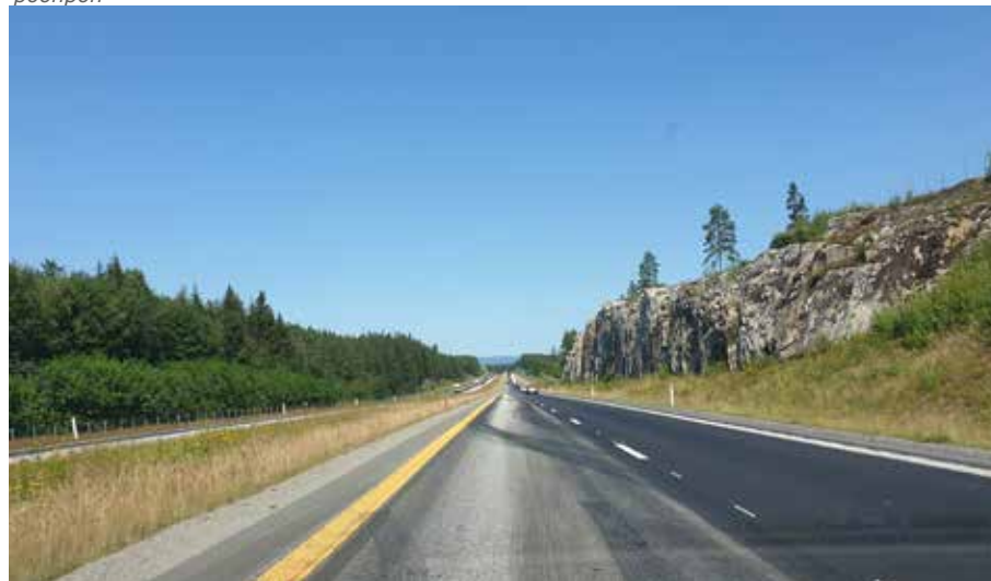
Fig 4.5: Eksempel på fin overgang mellom jordskjæring og fjellskjæring på vei E6 nord for Gardermoen. Foto: Marius Fiskevold.
