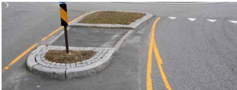
Fig. 5.27: Konsekvent utseende med gressflater innrammet av granittstein i refuger og i rundkjøringer gir et godt utformet og godt inntrykk i trafikkområdet på vei E6 ved siden av Mjøsa. Foto: Henrik Undeland.
