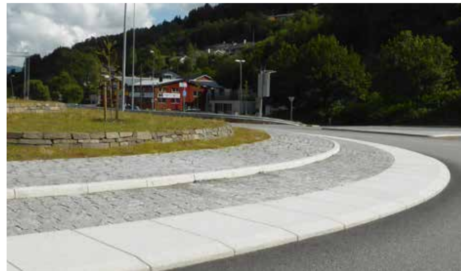
Fig. 5.28: Granittkant med høy bearbeidingsgrad i rundkjøring på E39 nordøst for Bergen. Foto: Henrik Undeland.
