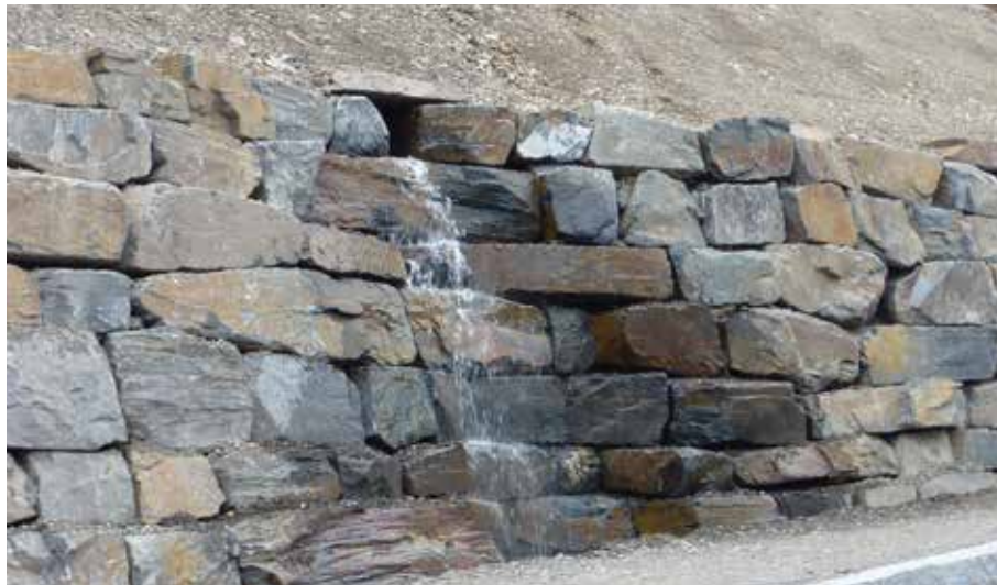
Fig. 4.18: Eksempel på håndtering av regnvann som ledes ved hjelp av fint utført steinarbeid. Foto: Henrik Undeland.
