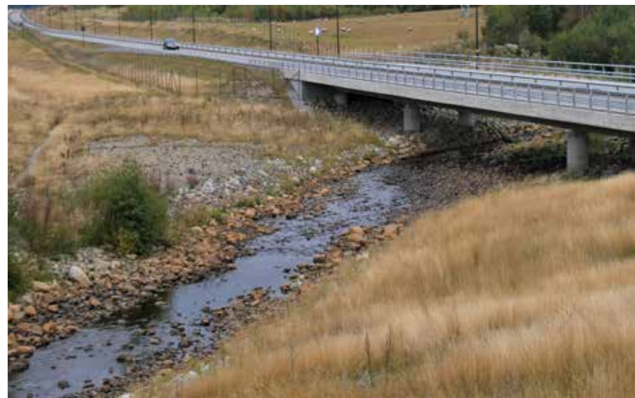
Fig 4.17: Vassdrag bør føres på tvers av veien på en naturlig måte slik at økologiske forbindelser opprettholdes, som her under Rv 3 ved Løten. Foto: Henrik Undeland
