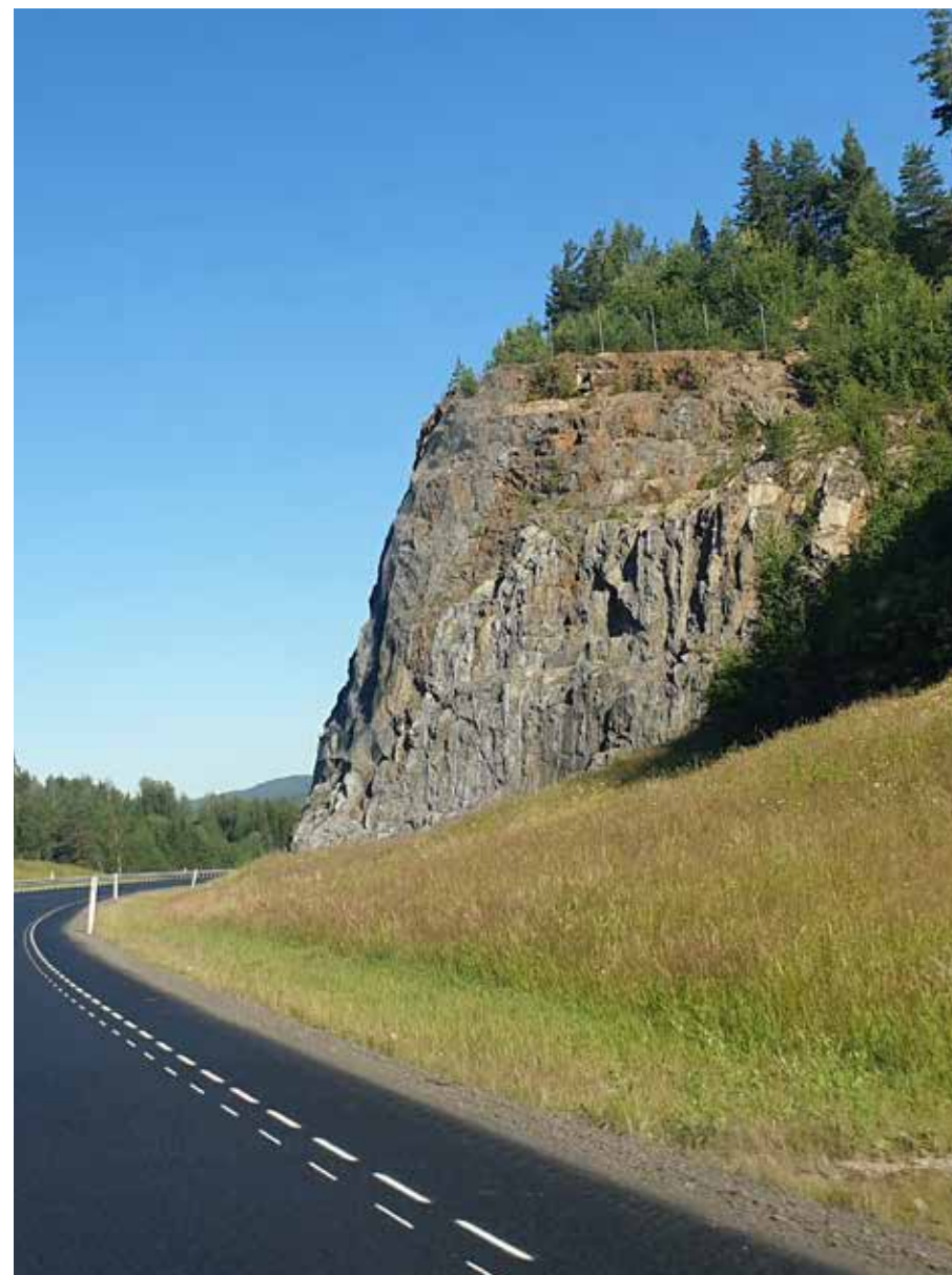
Fig 5.1 Fotografiet viser hvordan veien både kan tilpasses løsmasser i veiens sideterreng og fremheve spesielle bergformasjoner langs veien. Når dette gjøres planmessig og bevisst, fremstår også selve veien som et byggverk. Foto: Marius Fiskevold
