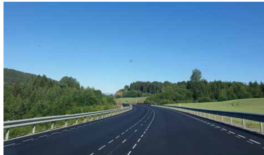
Fig. 4.16: Rv. 7 rett vest for Hønefoss. Den nye veien går nå på tvers av ravineformasjonene. Terrengbehandling har likevel gjort overgangene mindre tydelige og bidratt til å forankre veianlegget i området for øvrig. Foto: Marius Fiskevold
