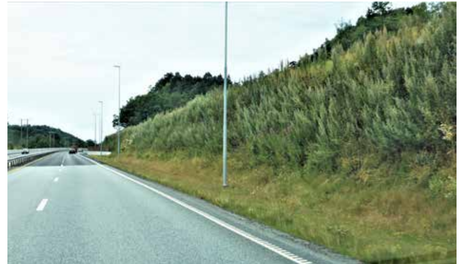
Fig. 3.14: Jordforsterket støyvoll med tett beplantning langs E39 i Søgne. Foto: Henrik Undeland.
