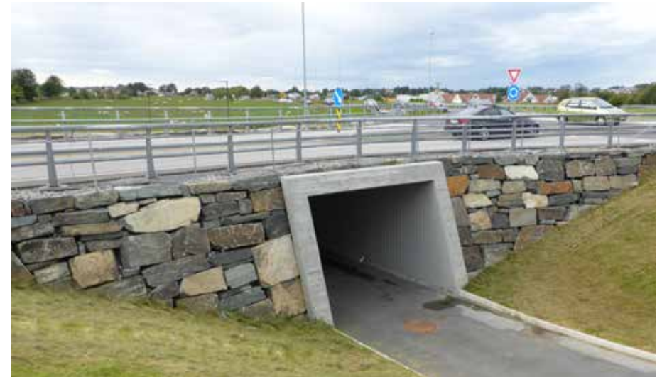
Fig. 5.15: En udergang for myke trafikanter under en tungt trafikkert E39 ved Stavanger. Vingemurer av naturstein langs veien og terrenget rundt skaper en god løsning for udergangens inn- og utgang. Foto: Henrik Undeland.
