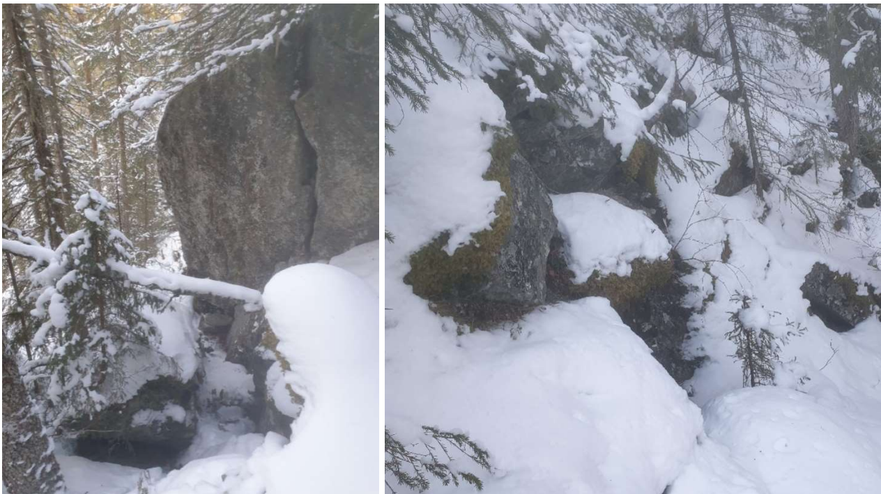
Figur 27: (18.01.2021) Eksempel på blokk som har løsnet og sprekk bak blokk på flere m 3 , sentralt i skråningen (venstre). Avløste blokker ved P9900 (høyre).
