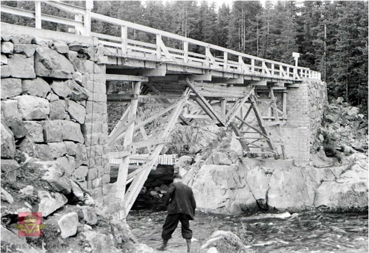
Kløftbrua 1940 (kilde: SVV)
