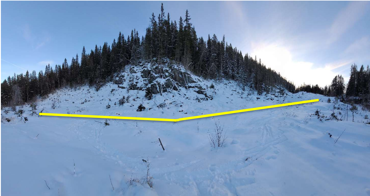
Figur 26: Panoramabilde tatt mot øst (18.01.2021). Den bratte skråningen fortsetter også inn i skogen. Veiskulderen er planlagt omtrent i skråningsfoten, indikert med gul linje.
