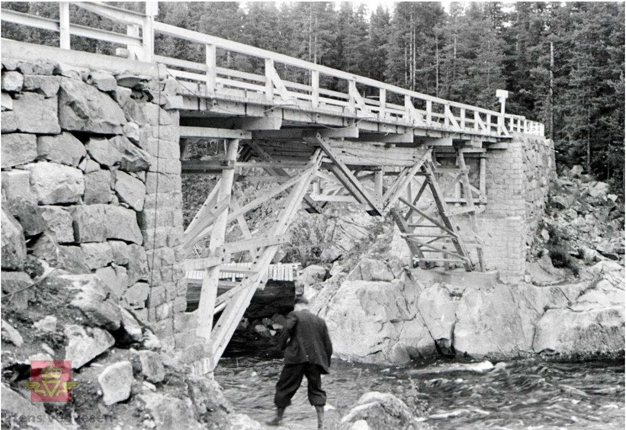
Kløftbrua (kilde: SVV)
