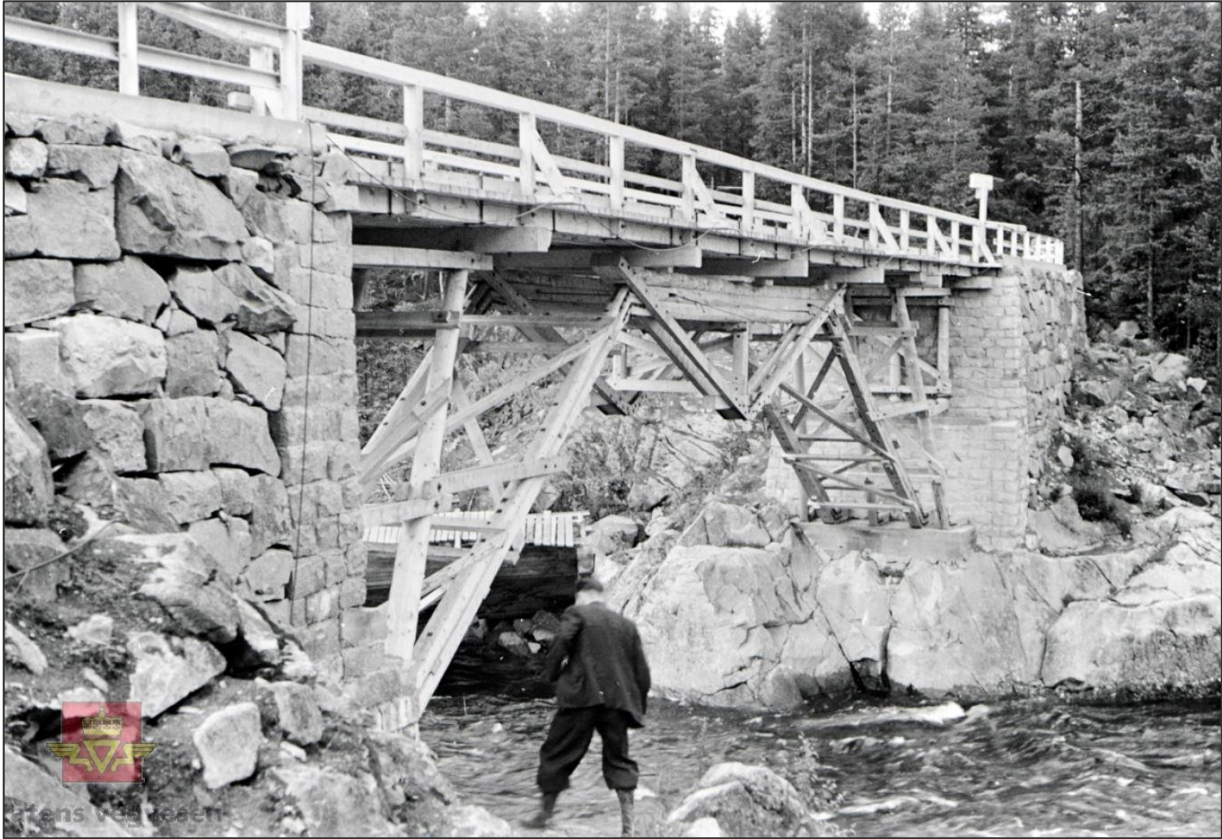
Kløftbrua 1940 (kilde: SVV)
