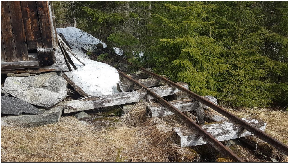
Figur 33: KM 9 - trallegang mellom sag og trelastlager.
