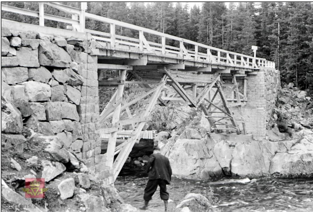
Figur 36: KM 10 - Midlertidig Kløft bru bygget av tyskerne i 1940 (Norsk Vegmuseum – ukjent fotograf 1940 – foto tatt mot øst).
