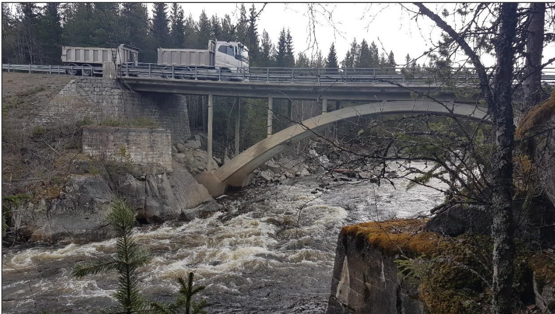
Figur 34: KM 10 – Foto av Kløft bru i dag med landkarene fra den gamle brua. Vestre landkar sees i forgrunnen til høyre nederst og østre landkar er til venstre ved dagens bru (under lastebil).
