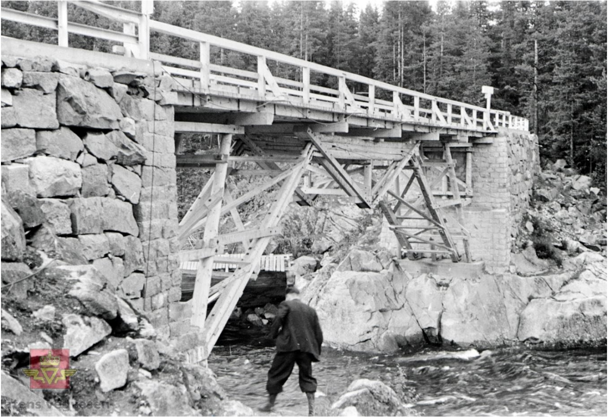
Kløftbrua 1940 (kilde: SVV)
