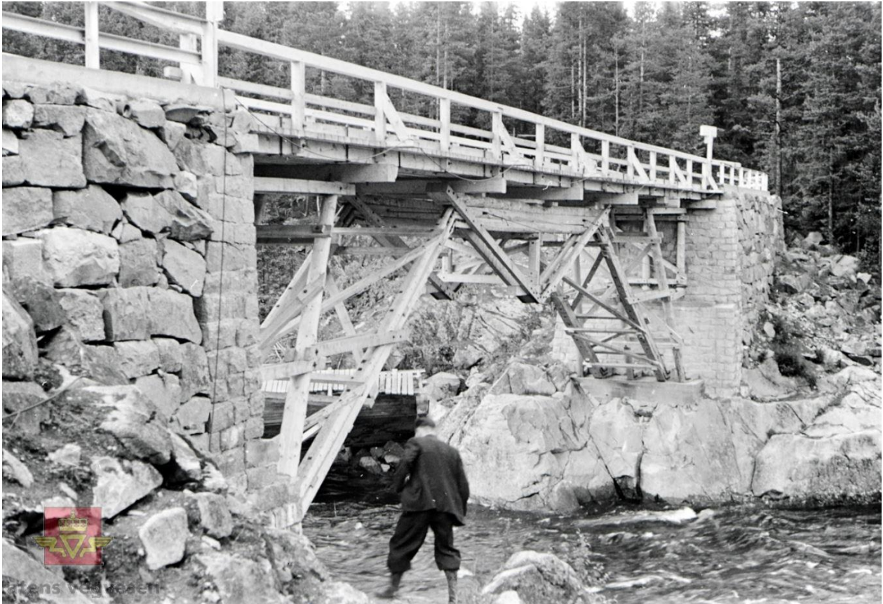
Kløftbrua 1940 (Kilde: SVV)
