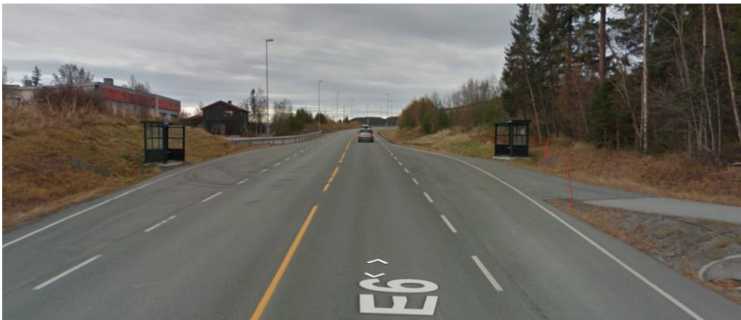
Figur 44 Dagens bussholdeplass Ulsberg på E6
