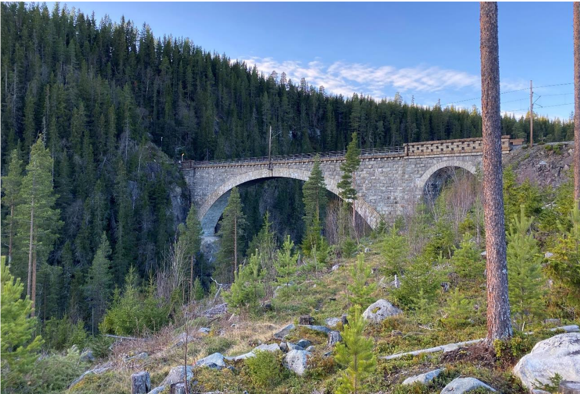
Figur 23: Fottur til Orkla bru går på en merket tursti fra Innset.
