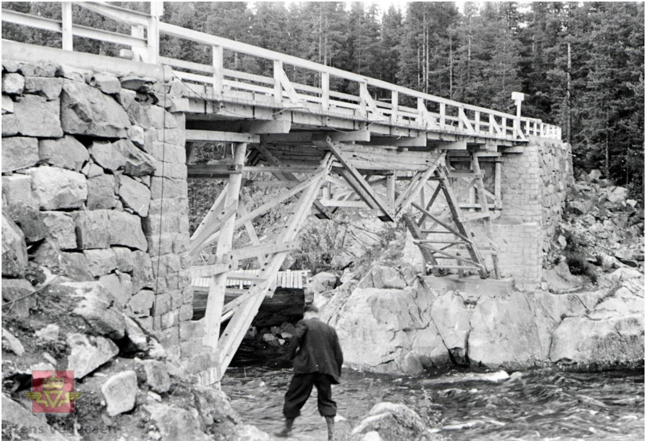
Kløftbrua 1940 (Kilde: SVV)
