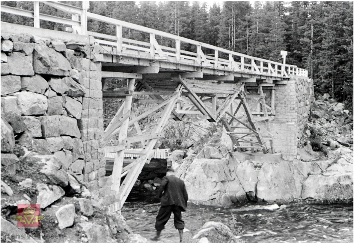
Kløftbrua 1940 (kilde: SVV)
