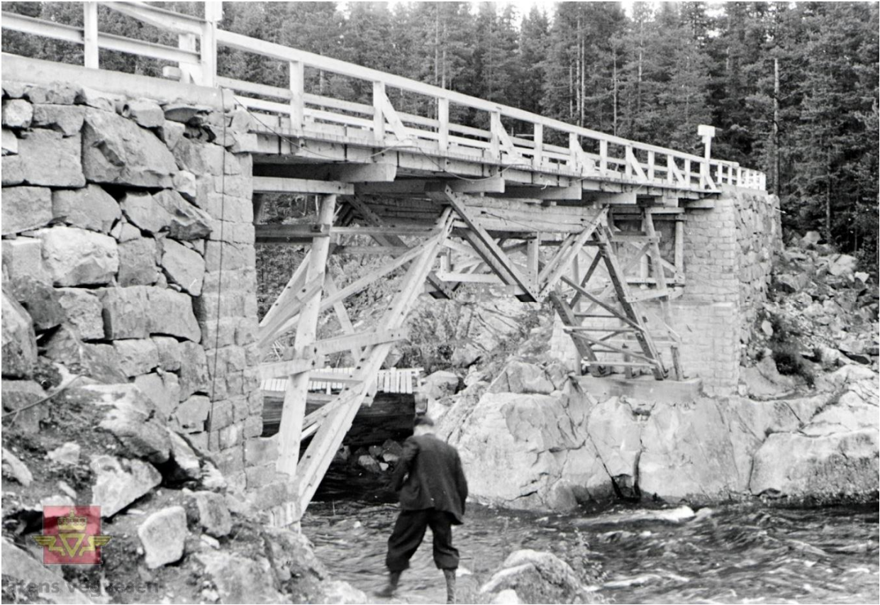
Kløftbrua 1940 (kilde: SVV)
