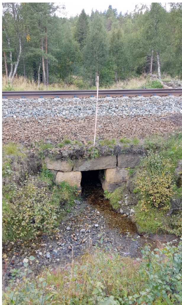
Fig. 10: Viser stikkrenne under jernbanelinje nedstrøms masseuttaket.
