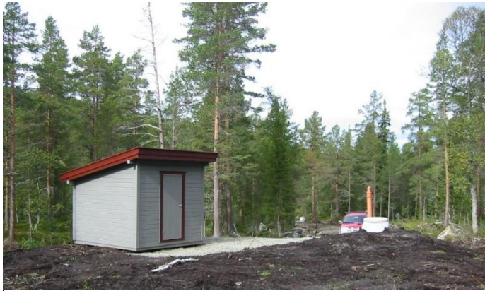
Figur 8: Innset vannverk, drikkevannsbasseng
