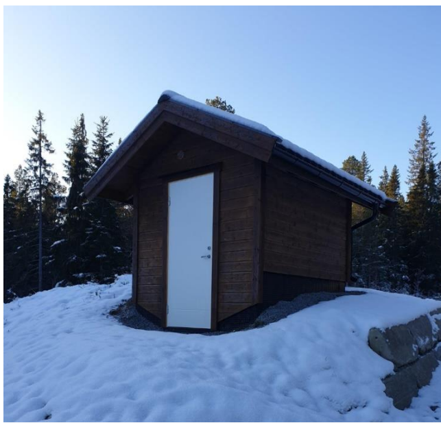
Figur 9: Havdal vannbehandlingsanlegg [Foto: Rennebu kommune]
