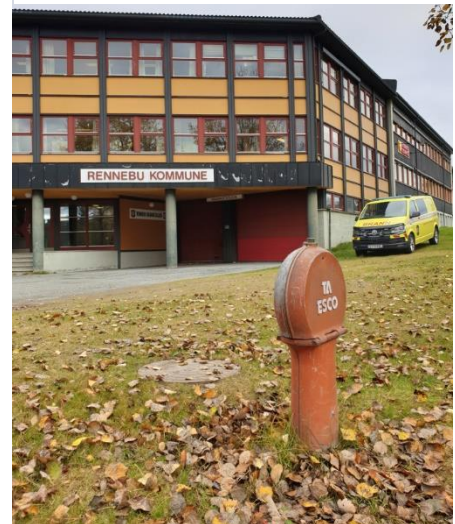
Figur 21: Kommunehuset i Rennebu kommune [Foto: Rambøll]
