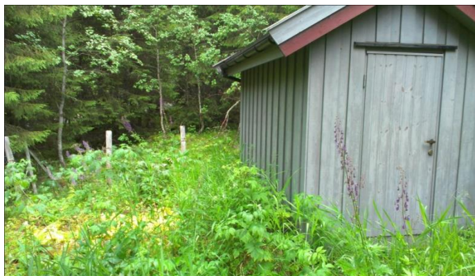
Figur 12: Jønnåbakken vannverk - utendørs (Foto: Rennebu kommune)
